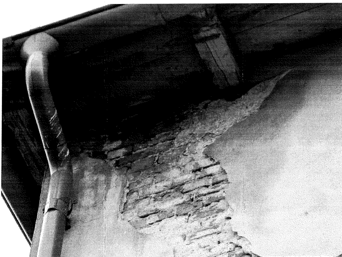
Fot.8. Ubytek w zbliżeniu (aut. Szymon Wójcik).
